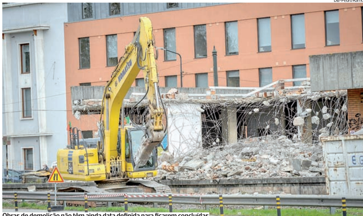
Obras de demolição não têm ainda data definida para ficarem concluídas
